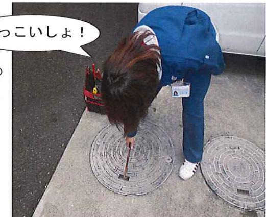
浄化槽のお世話は、使った後の汚れた水がどれだけきれいになっているかを調べたり、きれいになった水を消毒するために薬を入れたり、微生物が元気に働くことができるよう、浄化槽へ酸素を送る送風機の点検をしたりしています。
